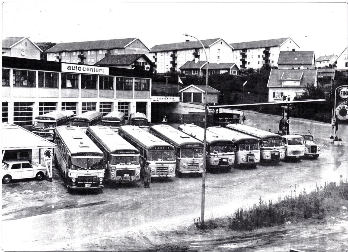
Rutebileier Reidar Johannessen foran 11 av sine 13 busser og 2 av sine 3 melkebiler. I bakgrunn det nybygde verksted og garasjebygget som var et eget firma med samme eier. Bildet tatt i 1963.
