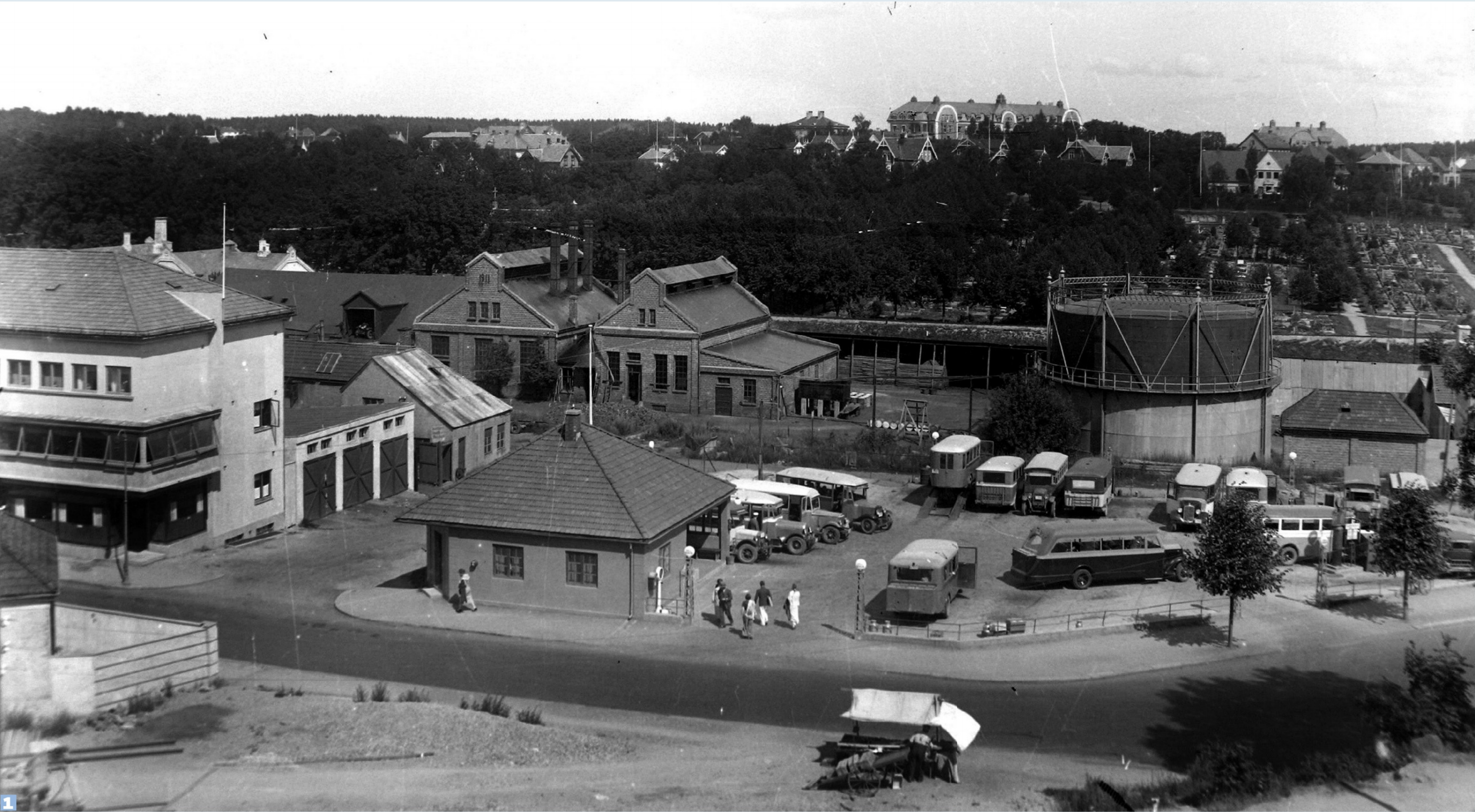
1: Den gamle rutebilstasjonen i krysset mellom Stoltenbergsgate og Slagenveien. Ved jernbanen sees byens gassverk. (Alle foto i artikkel utlånt av Slottsfjellsmuseet. Alle fotografert av Ansgar Th. Larsen (1875–1932) eller sønnen Asgeir Th. Larsen (1903–1989) 2: Tenvik-bussen med A. Hems gartneri i bakgrunnen. 3: Høytorvet 1923.
